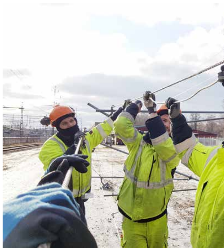
Kontaktledningsmontage på Trafikverksskolans markspann. FOTO: HUGO KULAS
